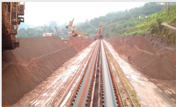
Figura 5: Implantação de drenagem lateral e recuperação da drenagem de fundo nos pátios de produto.
