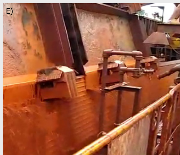
Figura 1: Registros de impactos durante o manuseio do minério a) Peneiramento com baixa taxa na Usina; b) Alta umidade no carregamento dos vagões; c) Entupimento de chutes de transferência de minério; d) Água livre na superfície do vagão na chegada ao Porto; e) Descarregamento no Porto.
